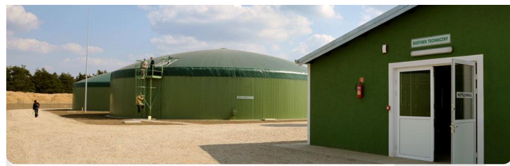
Fot. Biogazownia rolnicza należąca do firmy Poldanor
