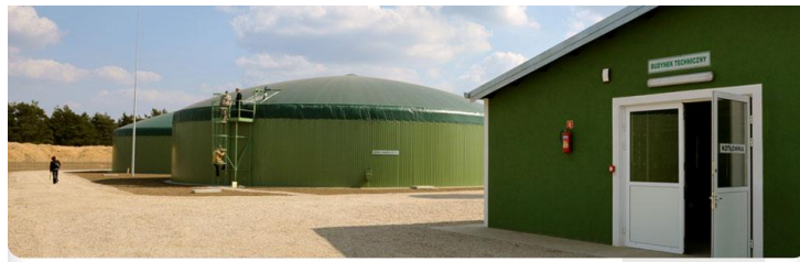
Fot. Biogazownia rolnicza należąca do firmy Poldanor
