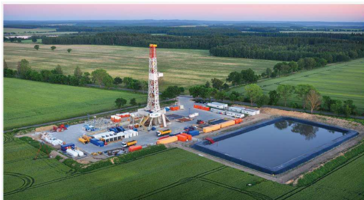
Fot. Próbnny odwiert w poszukiwaniu gazu łupkowego
