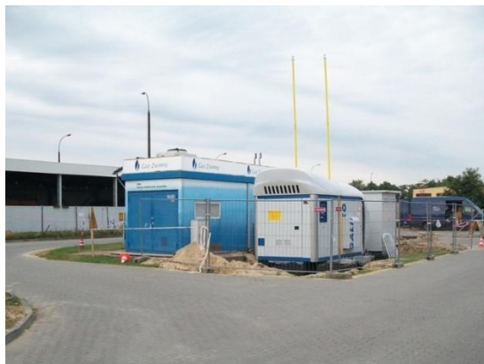
Fot. Modernizacja stacji CNG w Poznaniu
