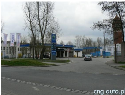
Fot. Stacja CNG we Wrocławiu
