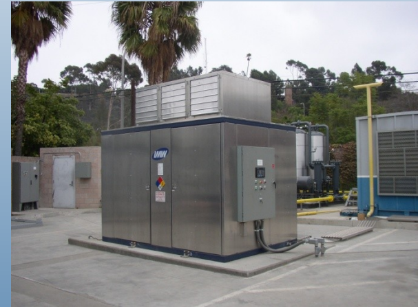
Zabudowa pojedynczego kompresora
